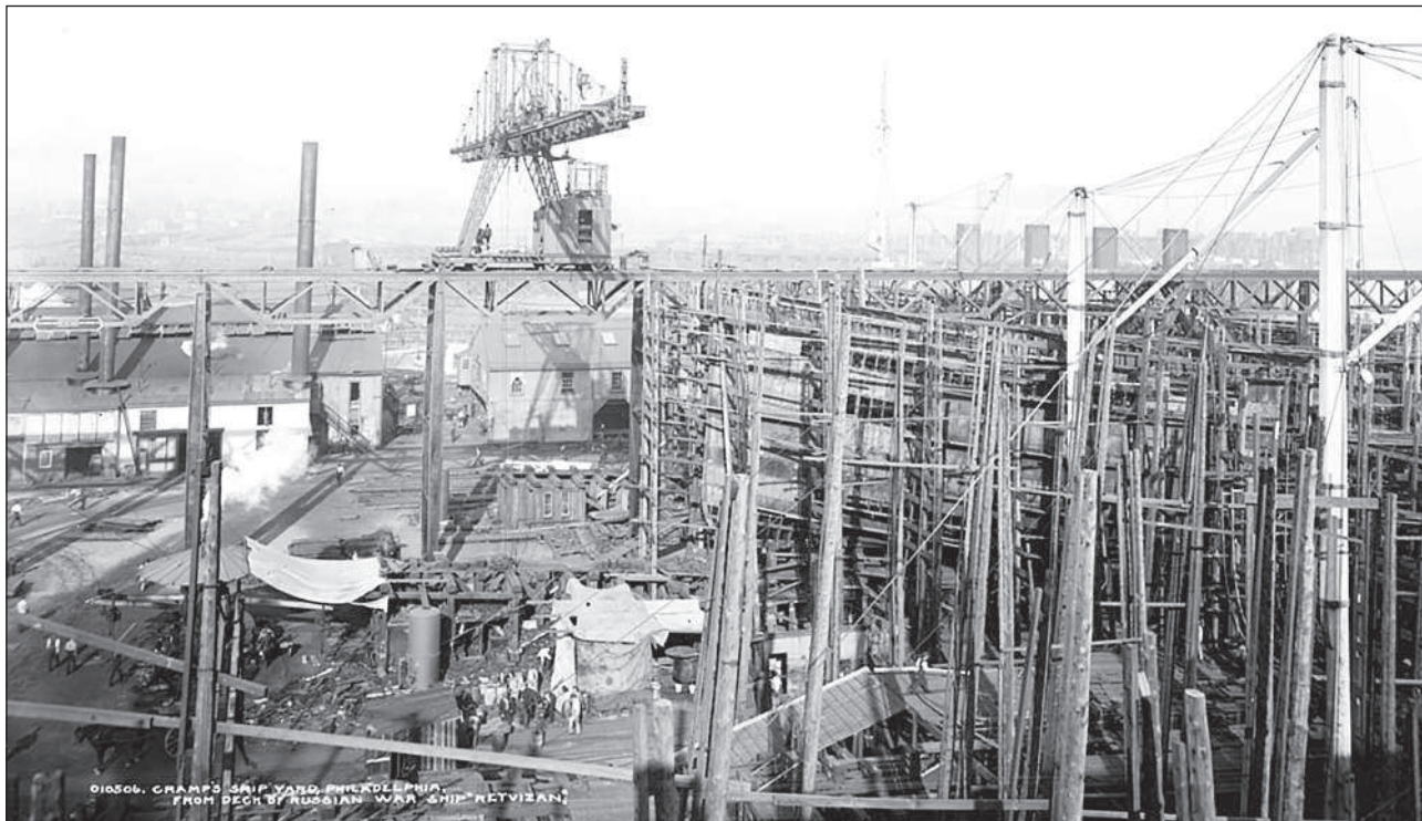
Корпус броненосца «Ретвизан» на стапеле. На верхнем снимке на дальнем плане видны трубы построенного здесь же крейсера «Варяг», 1900 г.
